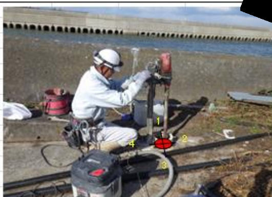
<コア削孔箇所>
